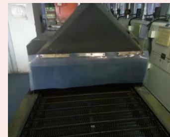
隧道爐更換擋風條
